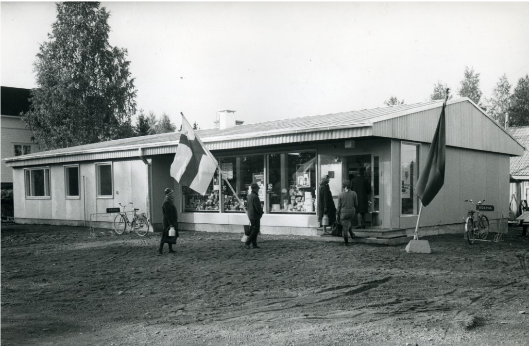
Kuva 4. Nykyinen matalamallinen rakennus, joka toimi kuvan ottohetkellä 26.9.1964 Osuusliike Voiman myymälänä (Staf, E. Osuusliike Voima, myymälä, m70).
