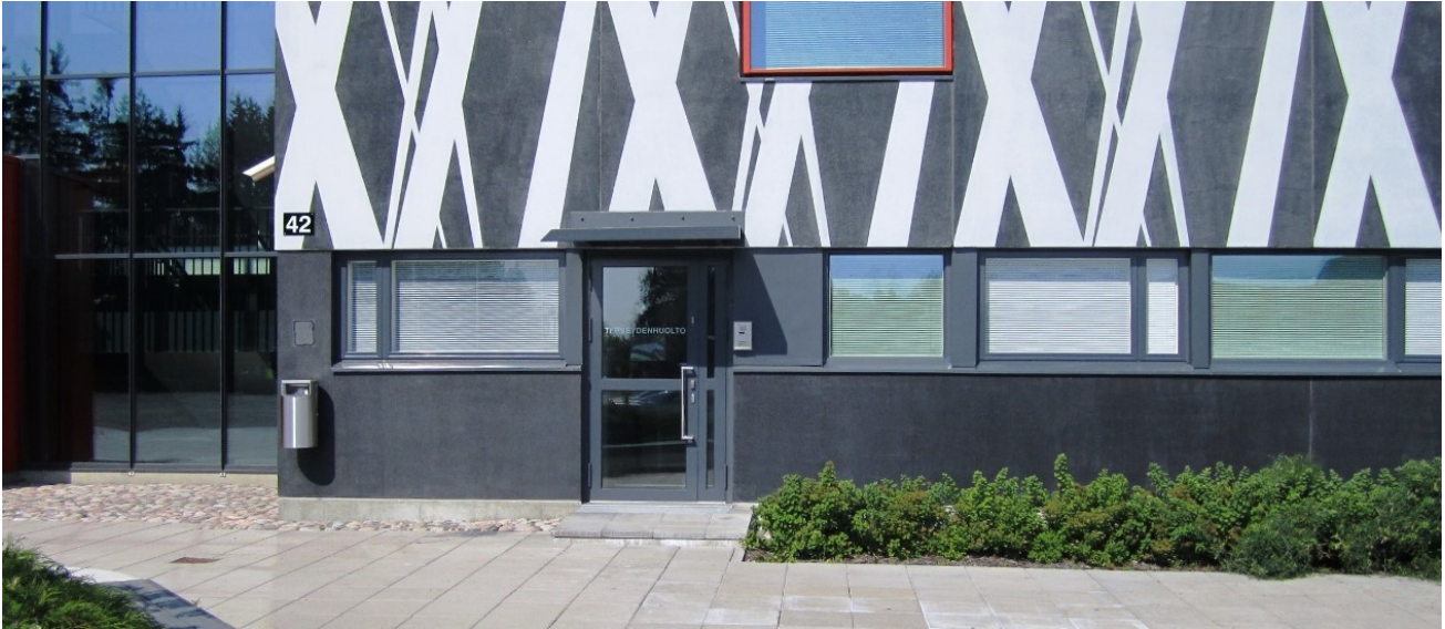
Pikkolan terveydenhoitajan ja koululääkärin sisäänkäynti Kangasalan lukion 1. kerroksessa
