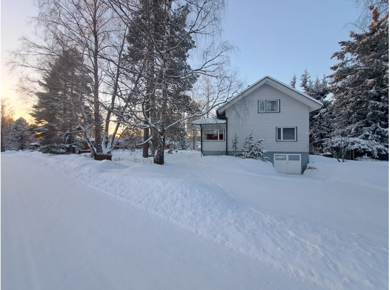
Kuva 3. Suunnittelualueen rakennuskantaa ja pihapiiriä.
