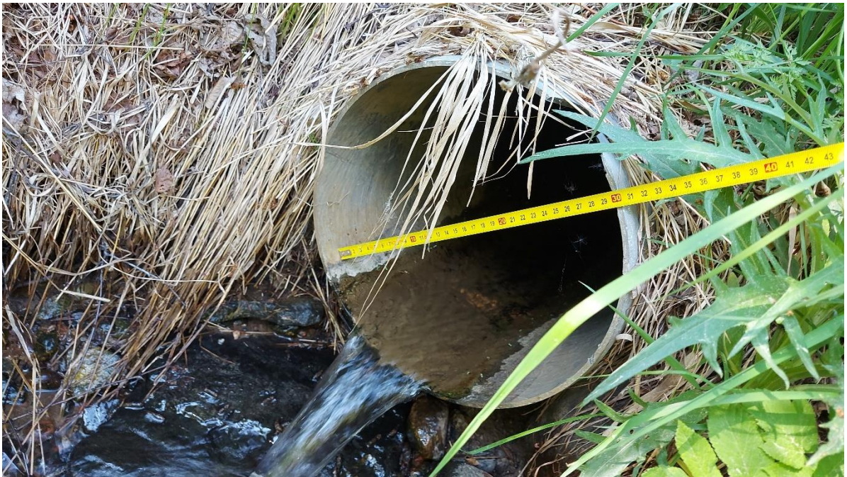
Kuva 2-6: Tuomaanpirtintie 15 kohdalla ajoväylän alla on nimettömässä uomassa rumpu 315 M.
