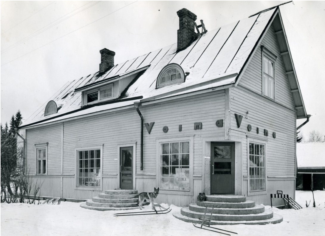
Kuva 3. Vuonna 1964 purettu vanha kihlakunnan kestikievarirakennus, joka toimi kuvan ottohetkellä Osuusliike Voiman myymälänä. (Staf, E. Osuusliike Voima, myymälä, m70).
