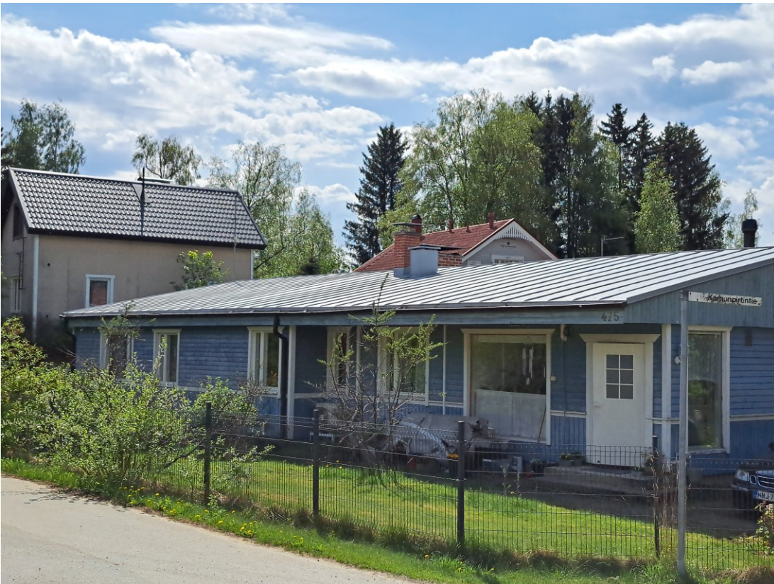
Kuva 5. Suunnittelualueella olevia rakennuksia. Kuva otettu 23.5.2023.
