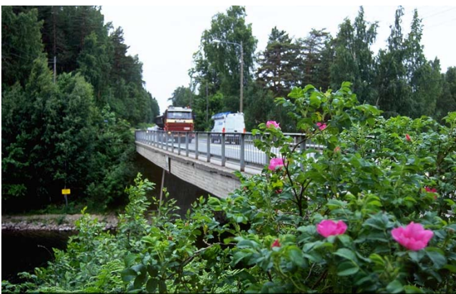
Kaivannon kanavan silta.
