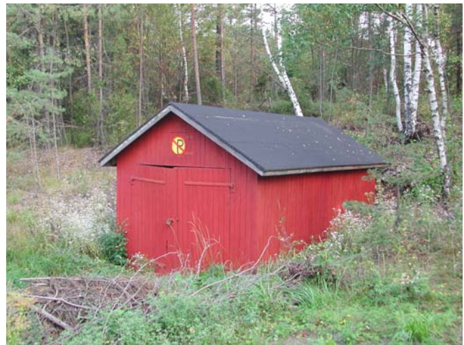
ja jälkeen kunnostuksen.
