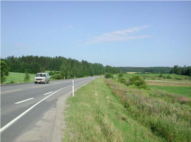
Leveä piennaralue, joka on niitetty sisäluiskan osalta.
